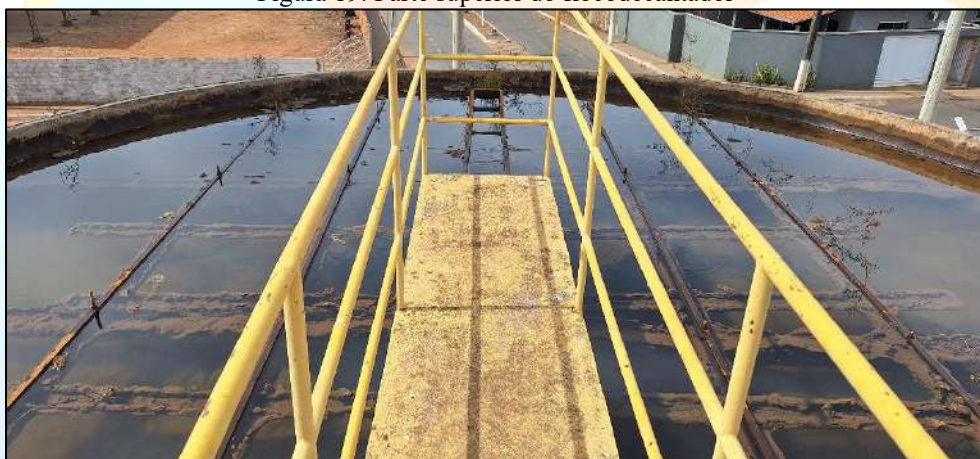
Figura 19: Parte superior do floccodecantador
