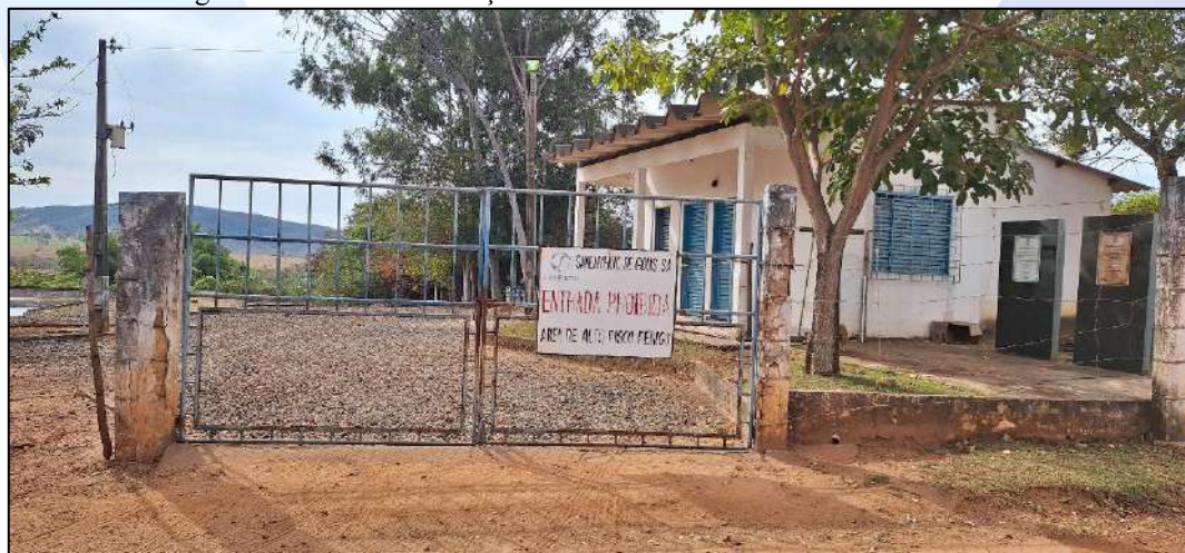
Figura 33: Portaria da estação de tratamento de efluentes de Corumbáiba
