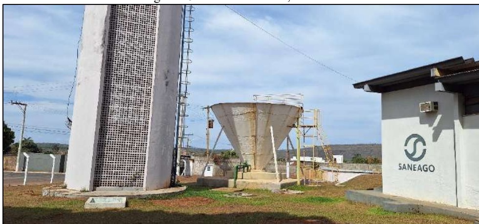
Figura 18: Floccodecantador, ao centro
