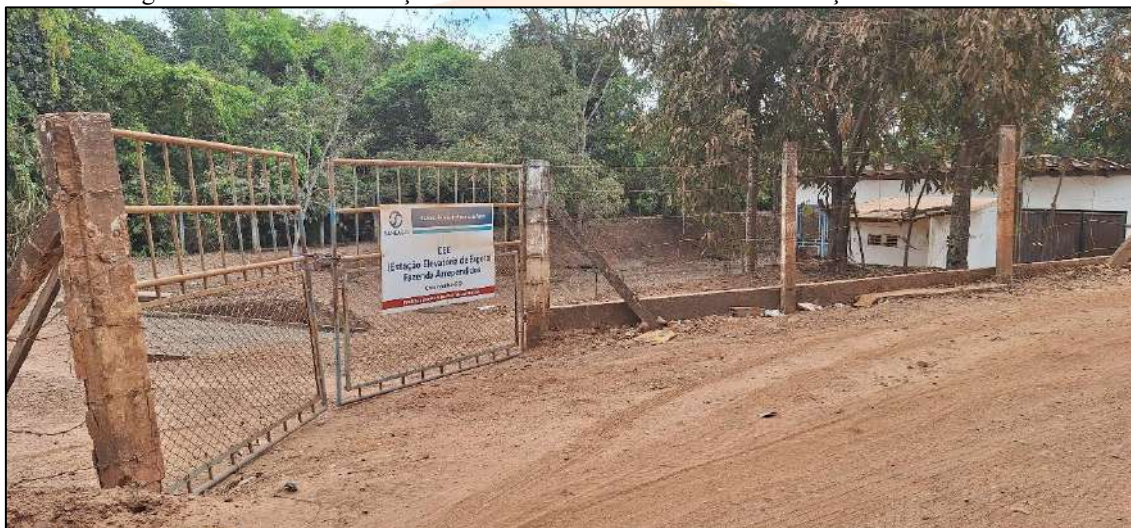
Figura 31: Portaria da estação elevatória localizada no sítio da estação de tratamento
