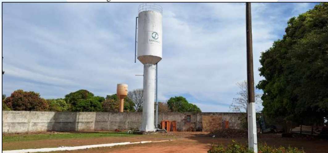
Figura 28: Reservatório elevado da ETA
