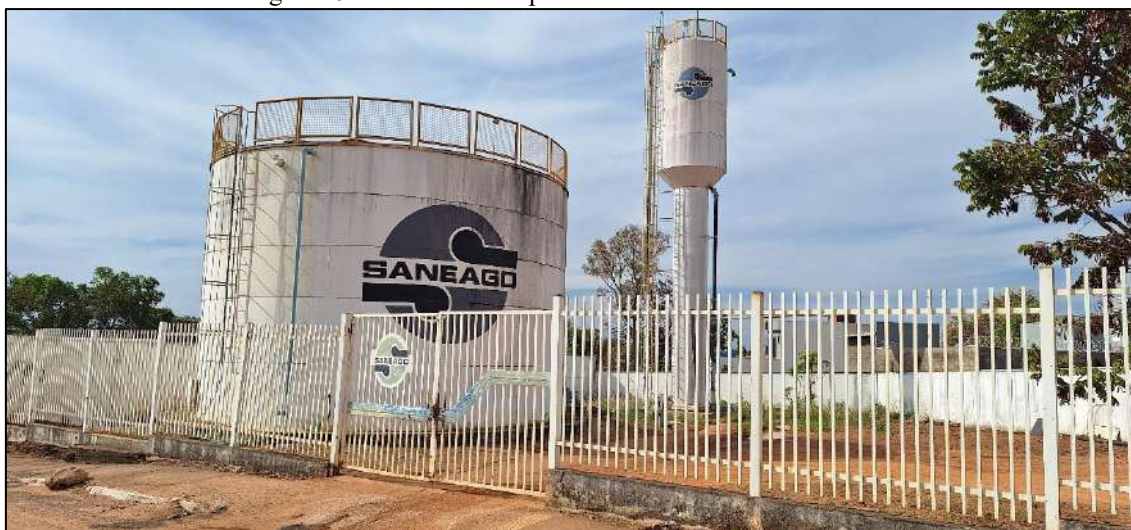
Figura 29: Reservatórios apoiado e elevado – Simon Bolívar
