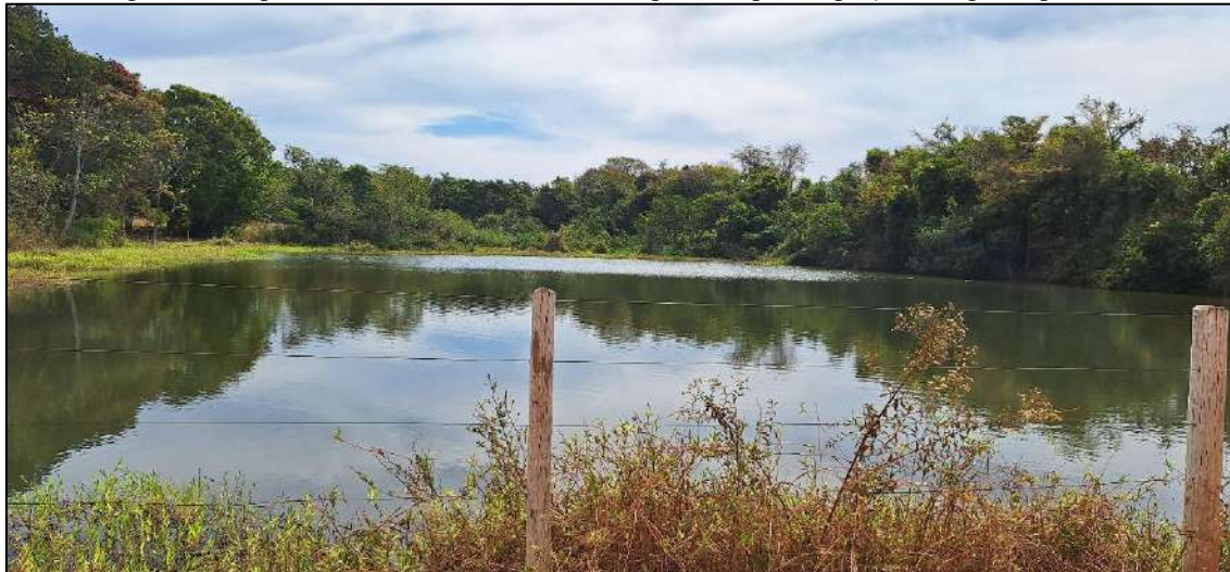
Figura 13: Represa construída no Ribeirão Arrependido para captação de água superficial
