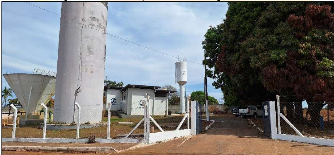
Figura 16: Entrada da Estação de Tratamento de Água de Corumbáiba
