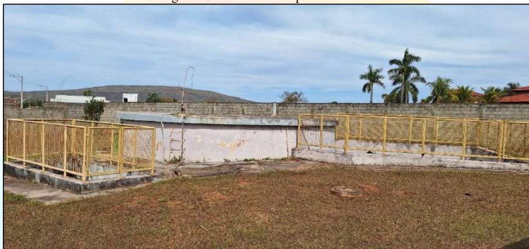
Figura 27: Reservatório apoiado da ETA
